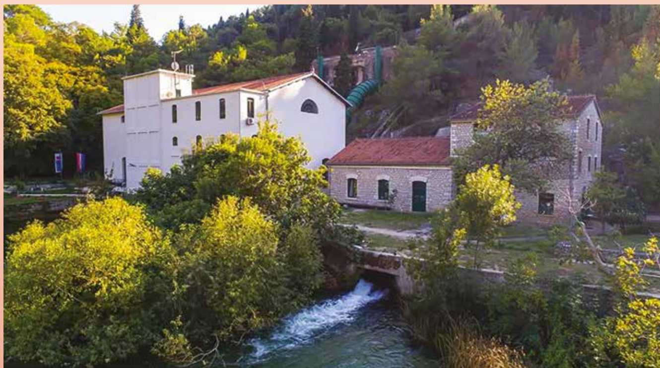
▲ Pogled na strojarnicu elektrane s rijeke...
