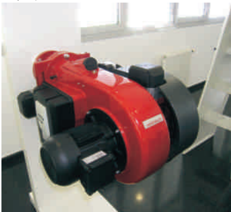
Slika 2 Obstoječi oljni gorilnik lahko zamenjamo s plinskim
