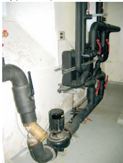
Slika 2 Štirje prenosniki toplote in obtočna črpalka
