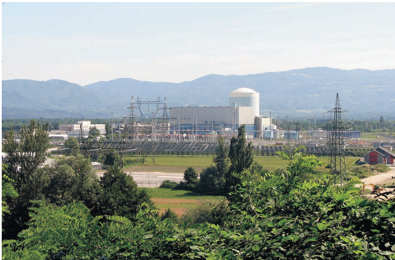
Slika 3 Daljnovod Krško - Beričevo se gradi že 30 let
