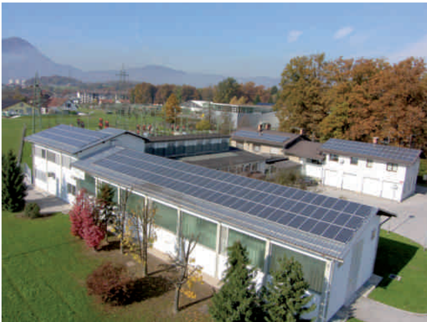
Slika 1 Sončna elektrarna Trata pri Škofji Loki inštalirane moči 43,74 kW p
